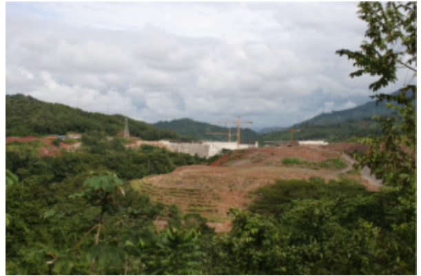
Weiträumige Absperrung der Baustelle.
