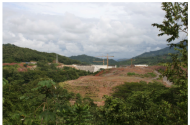
Weiträumige Absperrung der Baustelle.
