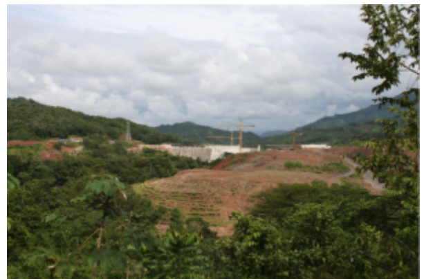
Weiträumige Absperrung der Baustelle.
