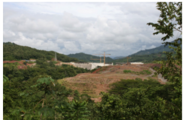
Weiträumige Absperrung der Baustelle.
