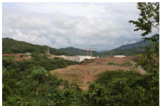
Weiträumige Absperrung der Baustelle.
