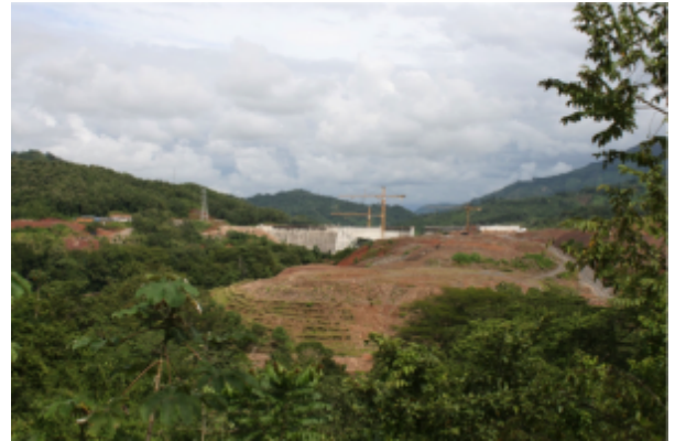
Weiträumige Absperrung der Baustelle.
