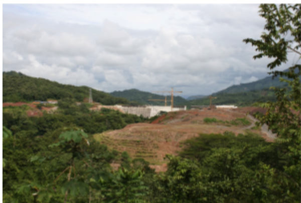
Weiträumige Absperrung der Baustelle.
